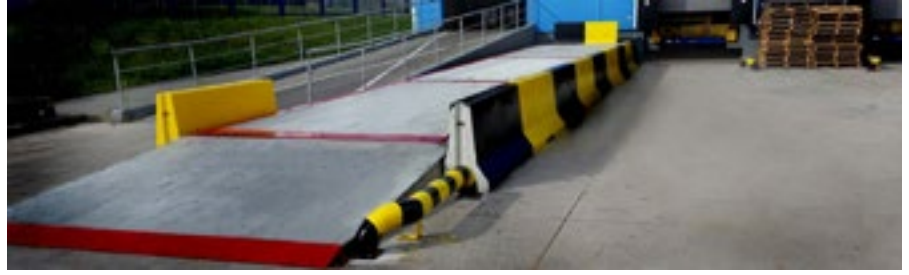
FOT. 3 Najazdowa waga samochodowa [źródło: Wagi Bydgoszcz]
