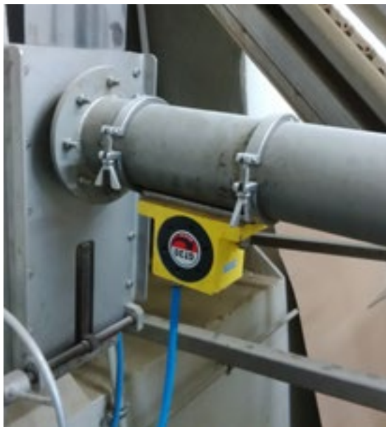
FOT. 3 Importowany i oferowany przez INWET SA turbinowy wibrator pneumatyczny typu GT [źródło: INWET]
